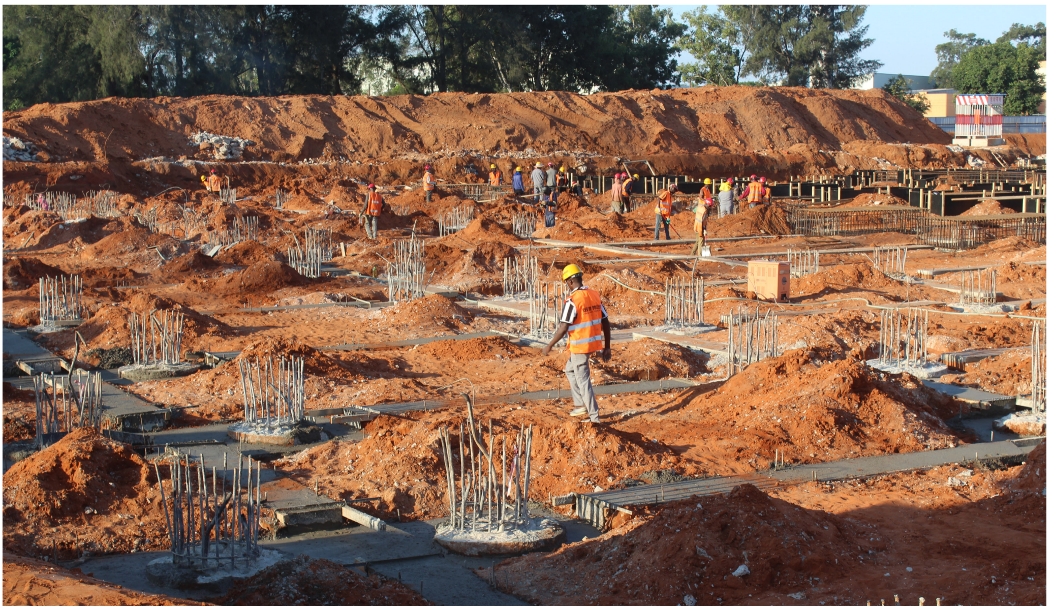
Obras das futuras instalações da Escola de Comunicação e Artes
